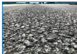
Nawierzchnia po śrutowaniu
